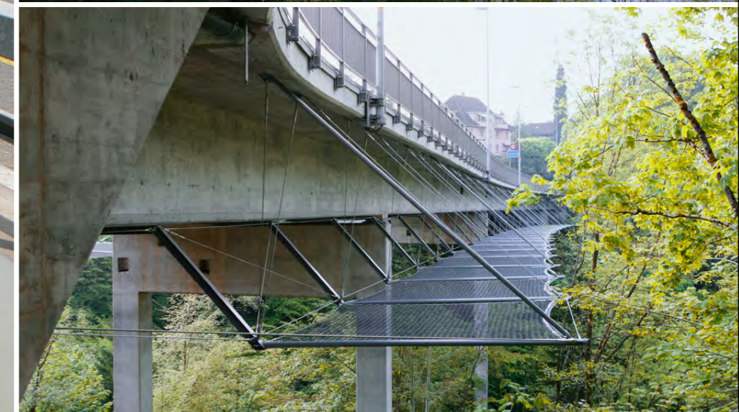
Rotbachbrücke, Rothenburg (CH)
