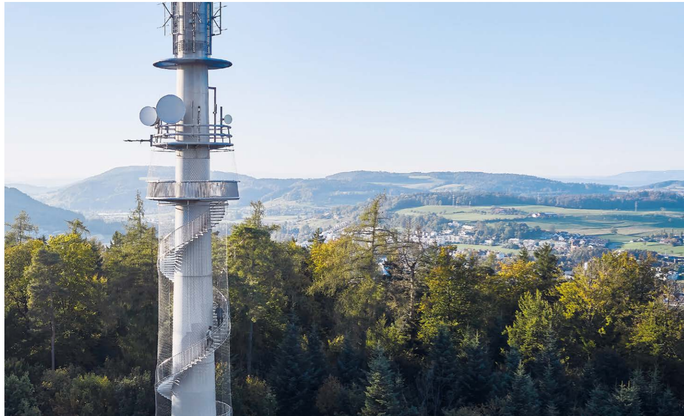
Vertikale Absturzicherung | Brühlbergturm Winterthur, Schweiz Protection verticale contre les chutes | Brühlbergturm de Winterthur, Suisse Vertical fall protection | Brühlbergturm Winterthur, Switzerland
